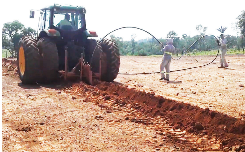
Enterrio de tubulação de polietileno.
