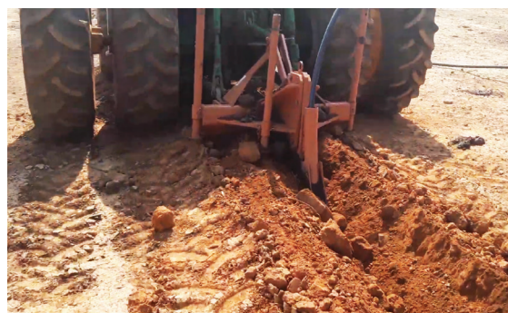
Enterrio de tubulação de polietileno.
